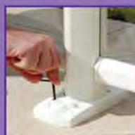
FIXAÇÃO AO SOLO - 2 PARAFUSOS (INOX Ø 8 MM)
