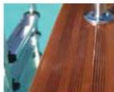
Escadas interiores em aço inoxidável
