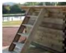
Escadas exteriores de madeira de pinho vermelho tratado
