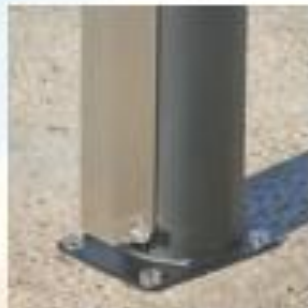
Fixação ao solo
