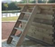
Escadas exteriores de madeira de pinho vermelho tratado
